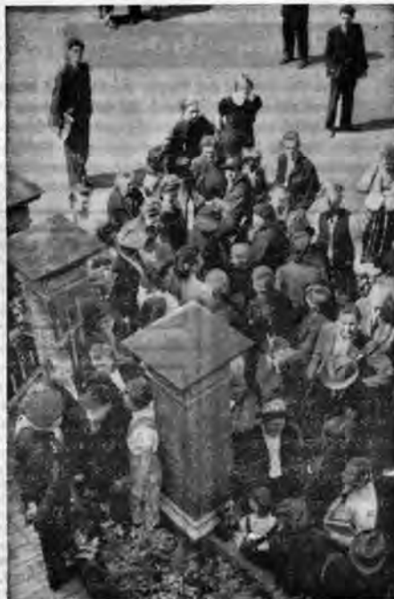
Die Menge drängt sich vor dem Eingang. Ein Polizist muß den Zugang verwehren.
